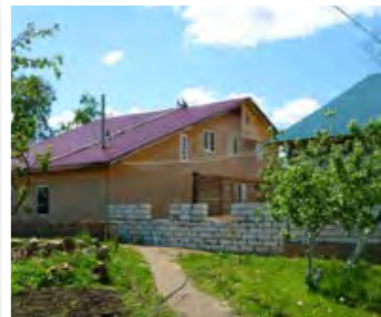
Строительство «Дома Пиркко» в Никулино, июнь 2012
